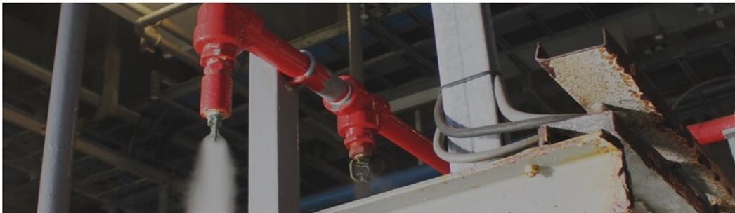
Figura 7: Teste de dilúvio a seco, utilizando fluido gasoso.
