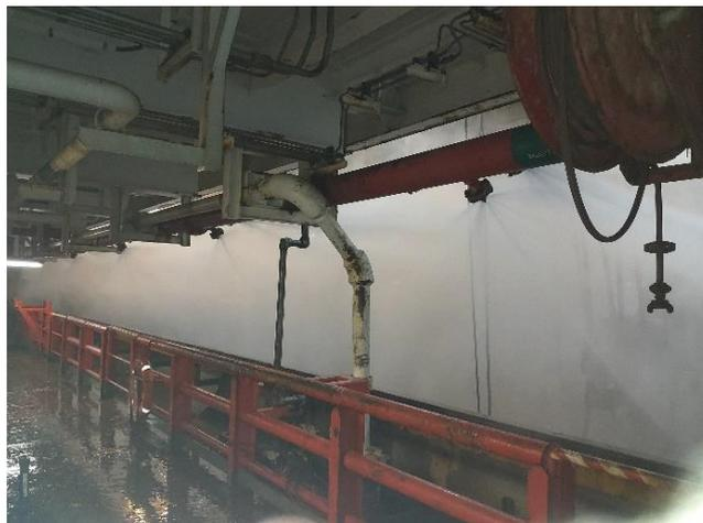
Figuras 1 e 2: Sistemas fixos de combate a incêndio por dilúvio
