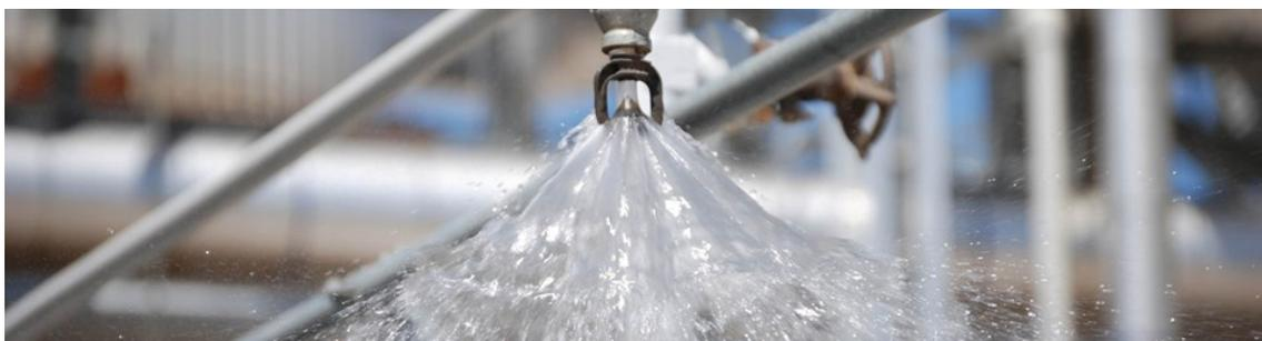
Figura 5: Teste molhado do dilúvio
